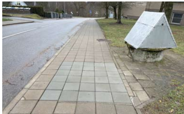
Šviesesnės plytelės išduoda vietą, kurioje augo medis. Kol kitur kelmai lieka ilgėliau, priešais savivaldybės Statybos skyriaus pastatą K. Ladigos gatvėje jis buvo greitai pašalintas.
